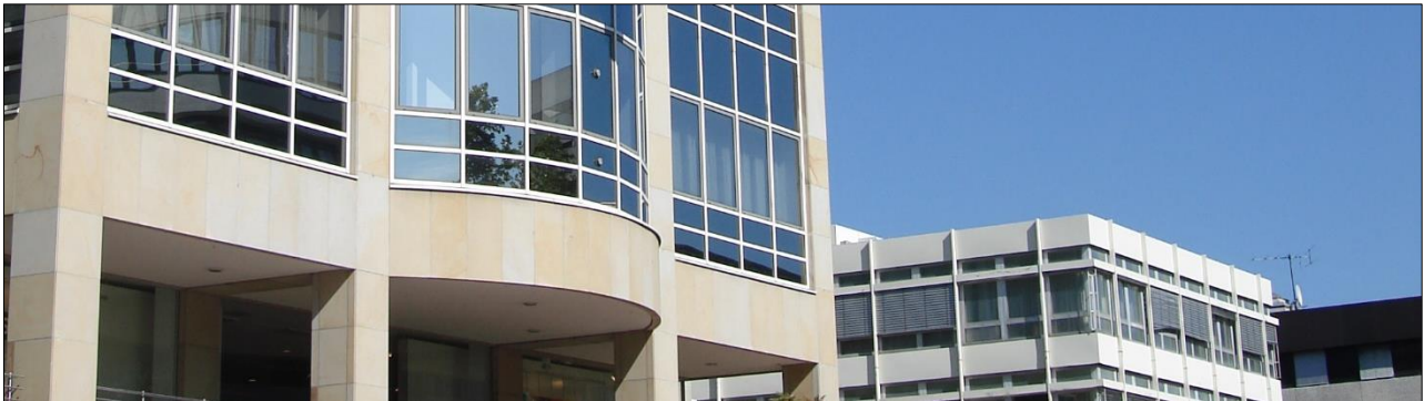
Östliche Karl-Friedrich-Straße 1-5, Pforzheim
